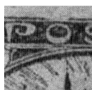
75/3 vyštipnutý rám nad O (POŠTA)
