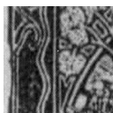
21/1 poškozený rám vlevo uprostřed
