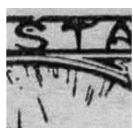
83/1 vyštípnutý rám nad Š (POŠTA)
